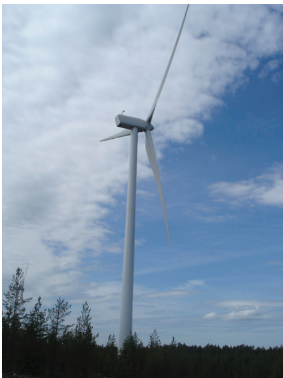
Vindkraftverk i Häcksta vindpark, Hudiksvalls kommun.
